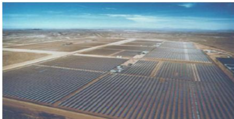
Vista aerea di 5 impianti parabolic trough da 30 MWe a Kramer Junction, California
